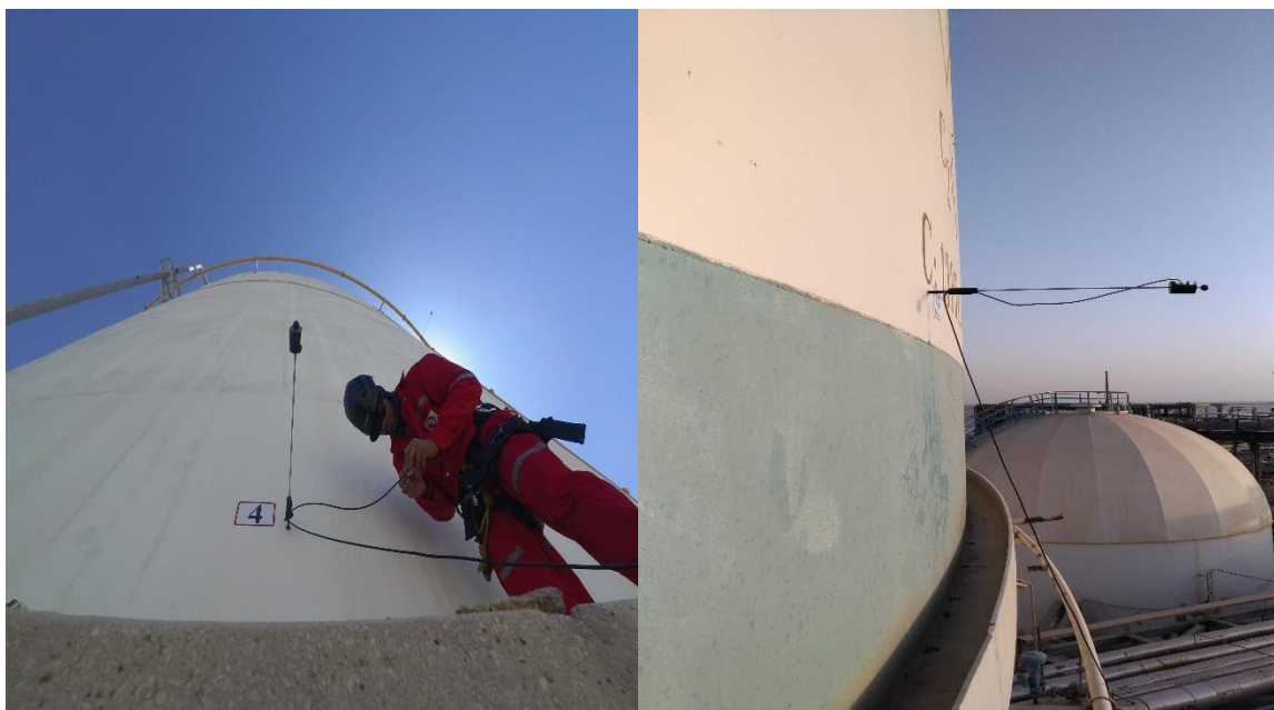
شکل ۷: نمایی از اتصال waveguide و سنسور به بدنه مخزن
