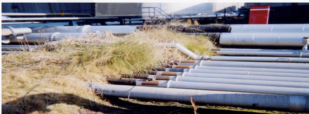
شکل ۱۰: لوله های نیمه مدفون.
