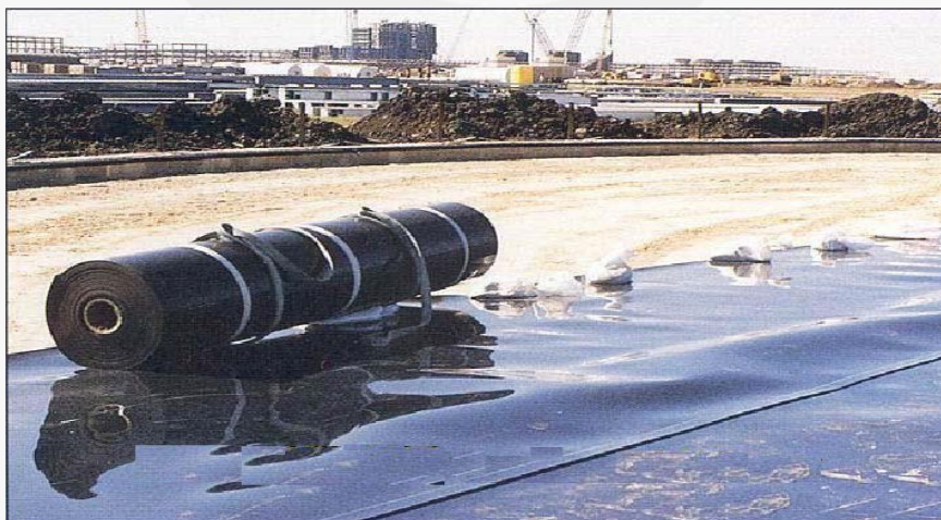
شکل ۳: اعمال پوشش بر روی فندآسیون محل نصب مخزن Above ground
