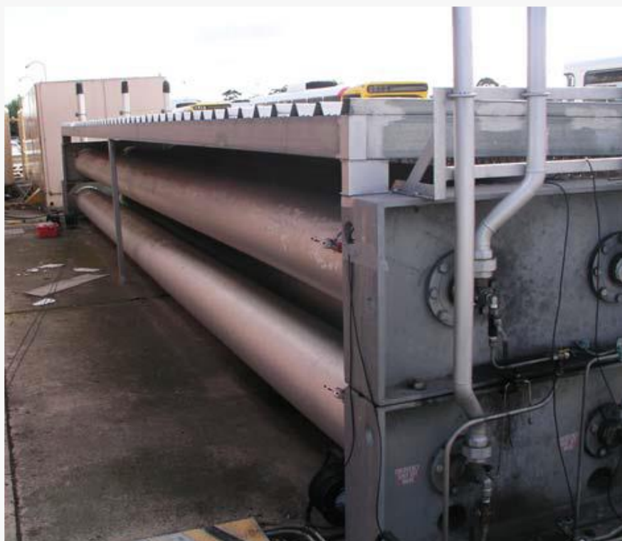
شکل ۳: سنسورهای نصب شده روی سیلندر ساکن
